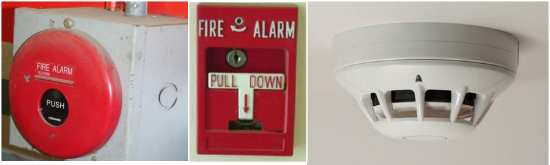
ภาพที่ 4-19 สัญญาณเตือนภัยแบบต่างๆ ได้แก่ สัญญาณเตือนภัย (Fire Alarm) และเครื่องตรวจจับควัน (Smoke Detector)ตามลำดับ
