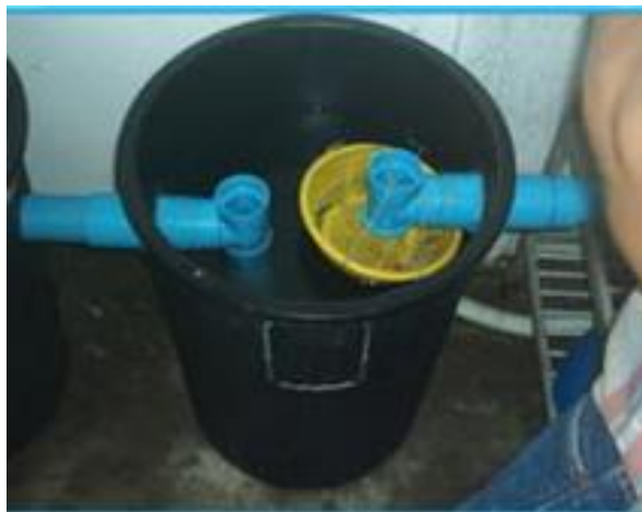
ภาพที่ 6-17 บ่อดักไขมันประดิษฐ์อย่างง่าย
