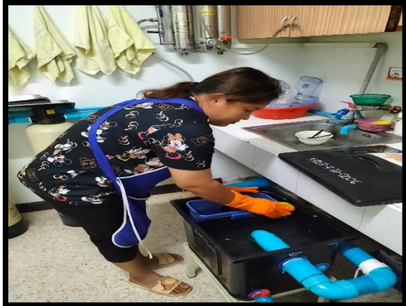
ภาพกิจกรรม แม่บ้านประจำชั้นของอาคารฯ ทำการล้างถังดักไขมันเป็นประจำทุกสัปดาห์
