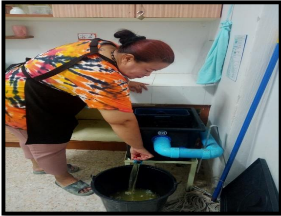
ภาพกิจกรรม แม่บ้านประจำชั้นของอาคารฯ ทำการล้างถังดักไขมันเป็นประจำทุกสัปดาห์
